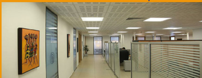
Cloisons & Plafond en plaque de plâtre & cloisons amovibles
